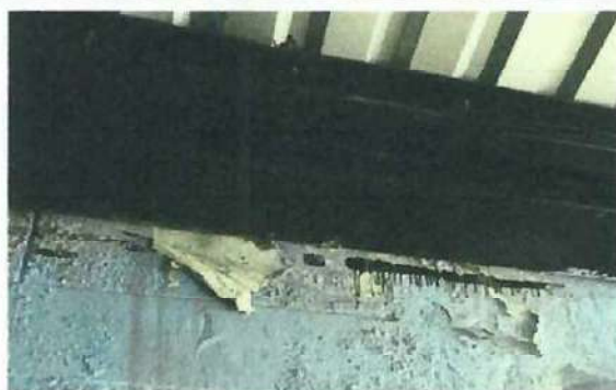
Foto 5: Sustrucción de canal de 22 mts de la cancha entechada
