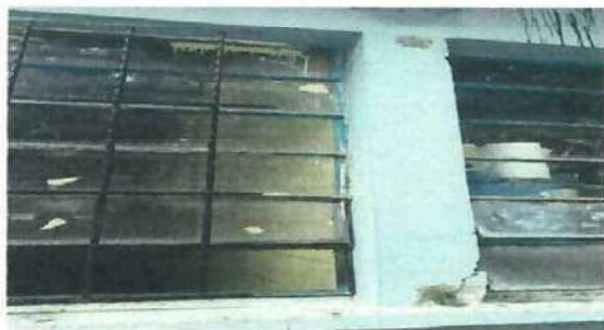
Foto 11: Sustitución de balcón.
