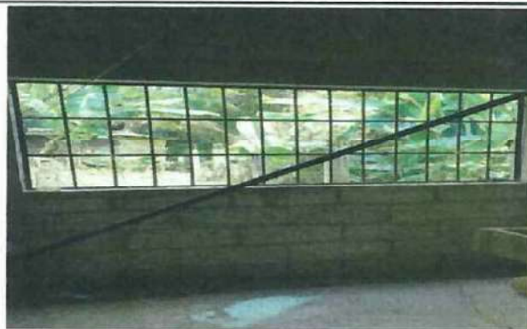
Foto 8: Instalación de doble cedazo a las ventanas de la cocina
