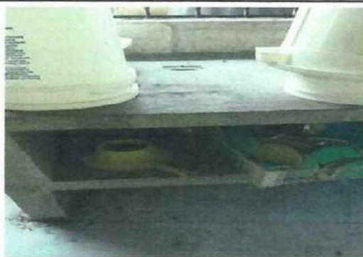
Foto 10: Colocación de azulejo en plancha de cemento para la cocina.
