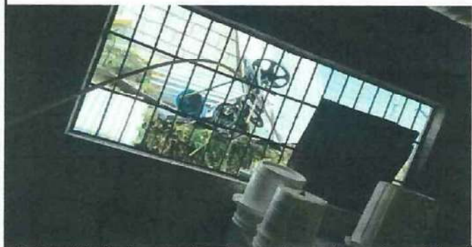
Foto7: Instalación de marco de madera y cedazo en las ventanas de la cocina para evitar la entrada de roedores e insectos.
