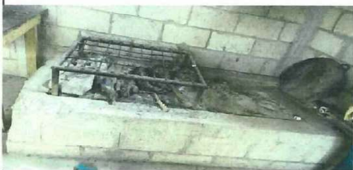
Foto 9: Sustitución de parrillas y reparación de polletón
